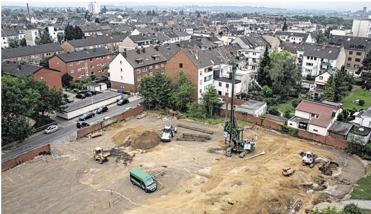
Die Baustelle am Krankenhaus sieht noch unscheinbar aus. Derzeit erfolgen Bohrungen, damit die Bodenplatte auf Betonsäulen verankert werden kann. Die beiden Ärztehäuser sollen bis Mitte nächsten Jahres fertiggestellt sein. Foto: Burkhard Giesen
