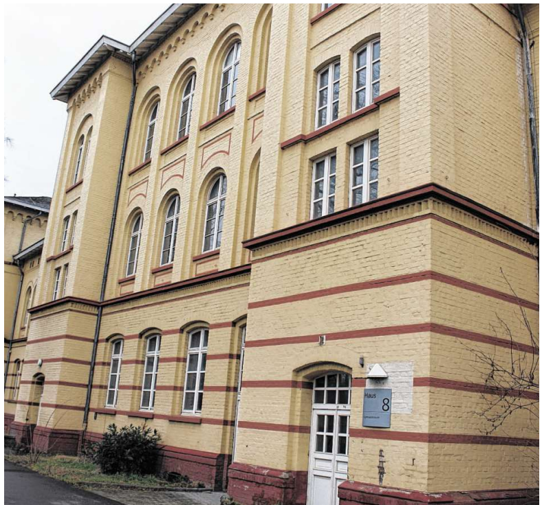
Das leerstehende Haus 8 auf dem LVR-Gelände soll der neue Standort für eine gemeinsame Krankenpflegeschule des Krankenhauses Düren und der LVR-Klinik werden. Bis Ende 2018 soll die Sanierung des Gebäudes abgeschlossen sein.
