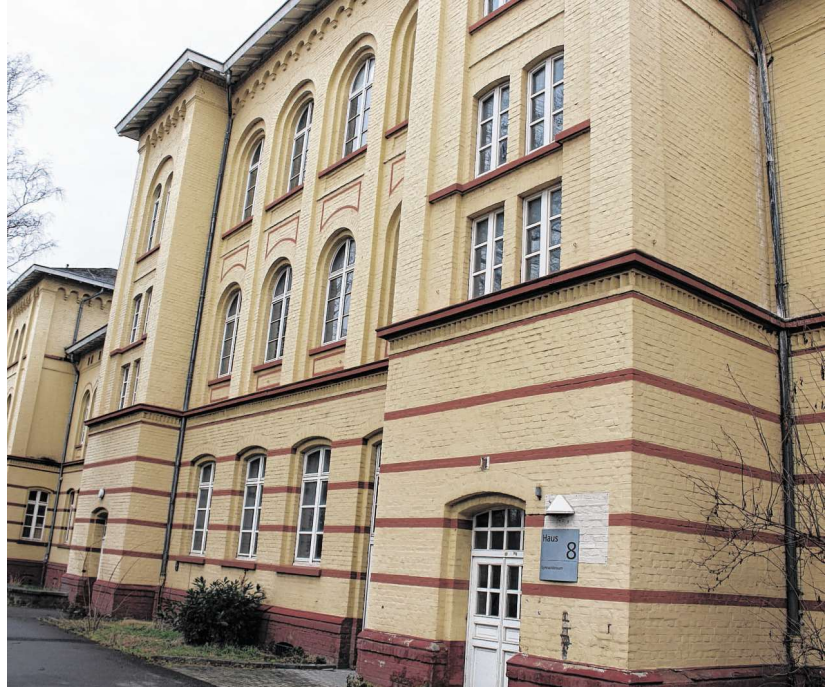
Das leerstehende Haus 8 auf dem LVR-Gelände soll der neue Standort für eine gemeinsame Krankenpflegeschule des Krankenhauses Düren und der LVR-Klinik werden. Bis Ende 2018 soll die Sanierung des Gebäudes abgeschlossen sein.
