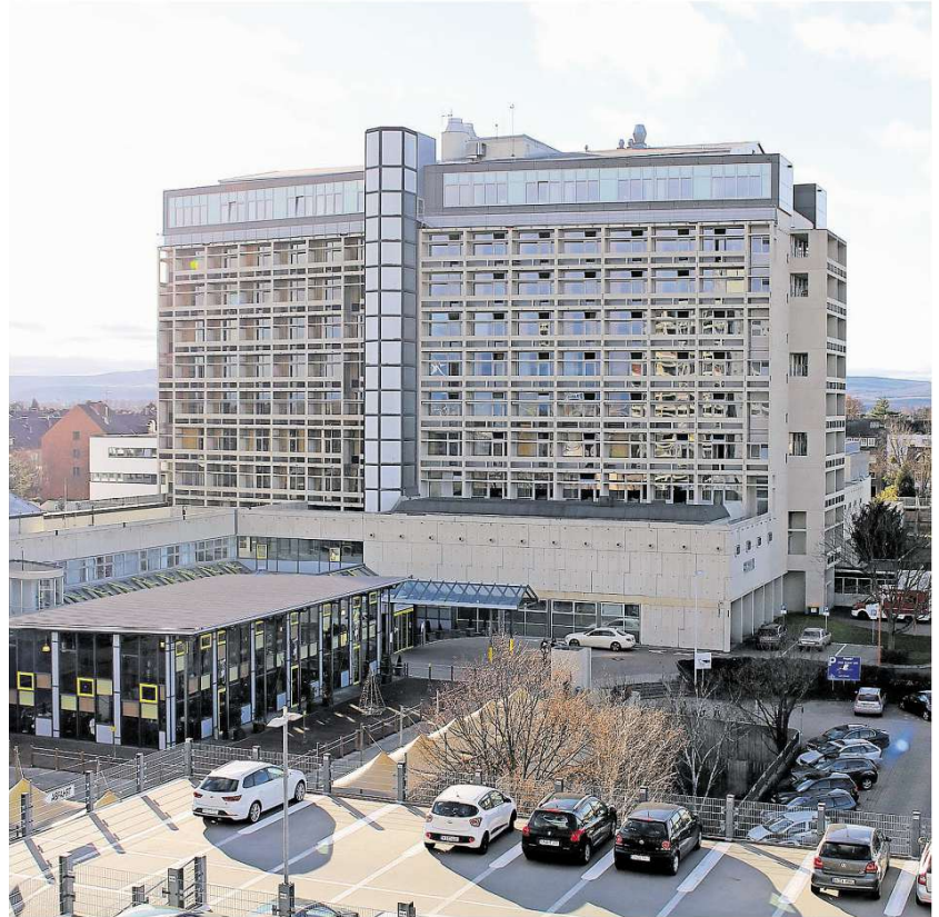
Neben der Grunderneuerung werden weitere 30 Millionen Euro in barrierefreies Wohnen investiert.
