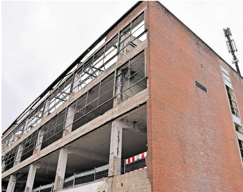
Da, wo derzeit noch alte Industriehallen stehen, soll demnächst die moderne Großküche ihren Platz finden. Einen ersten Plan für die Küche gibt es schon. FOTOS: SANDRA KINKEL
